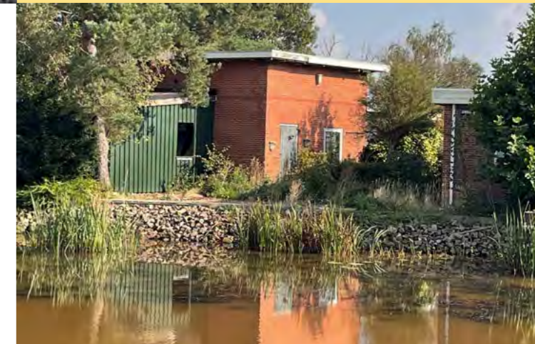
Huidige situatie gemaalgebouw Schildwolde
